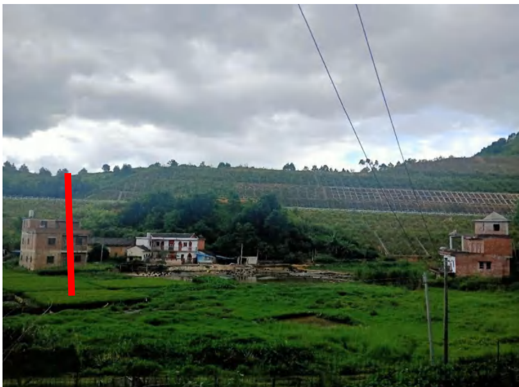
图 3.4-9 S19 兴华高速穿越现场照片
