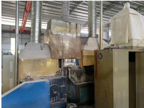
废气收集设施（集气罩+塑料垂帘）
