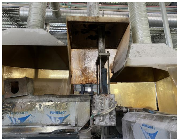
废气收集设施（集气罩+塑料垂帘）
