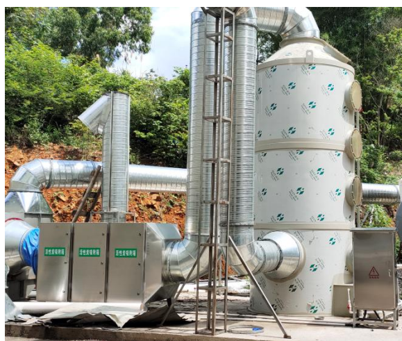
废气处理设施（水喷淋+活性炭吸附装置+15m 高排气筒）
