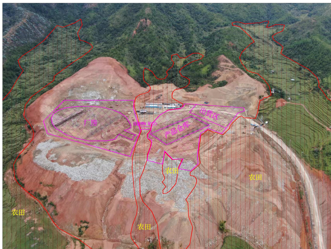
图 3-2 厂房平整区已损毁土地位置示意图（航拍图，拍摄于 2021 年 11 月）
