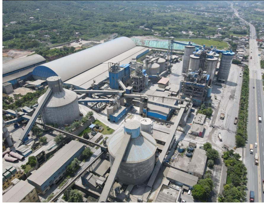
水泥制备及成品发运区
