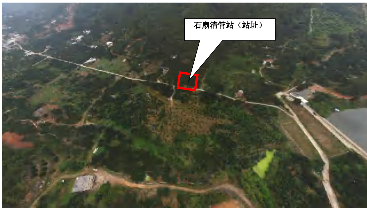
图 3.4-21 石扇清管站站址现状图
