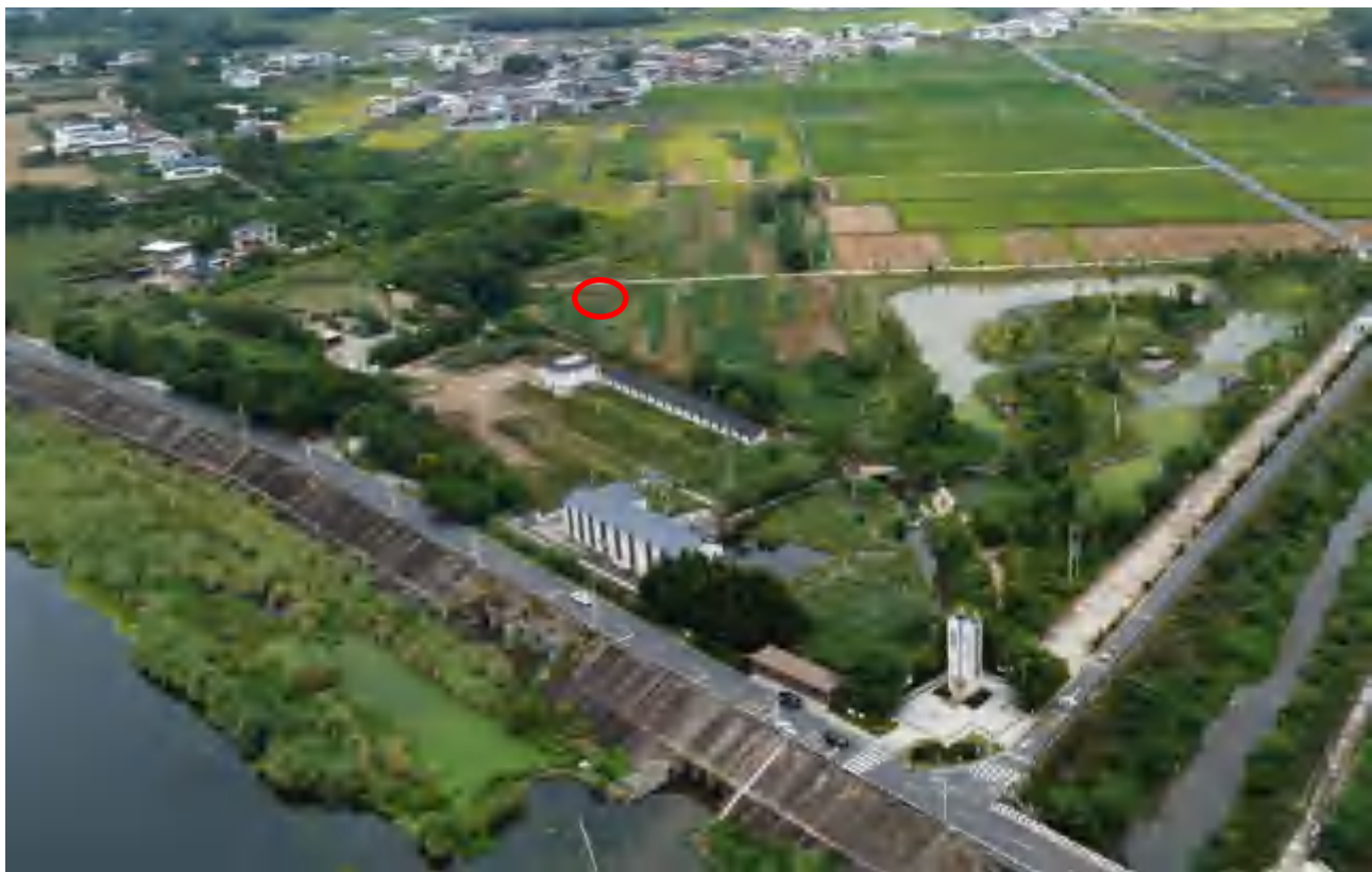
图 3.4-13 左岸始发井地貌现状图
