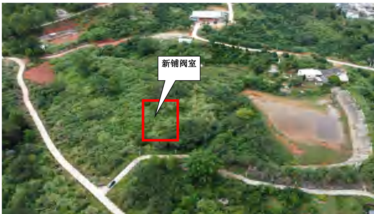
图 3.4-27 新铺阀室场址现状图
