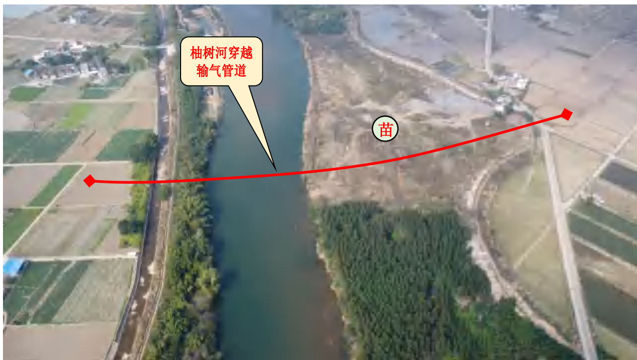
图 3.4-8 柚树河穿越现场地形地貌
