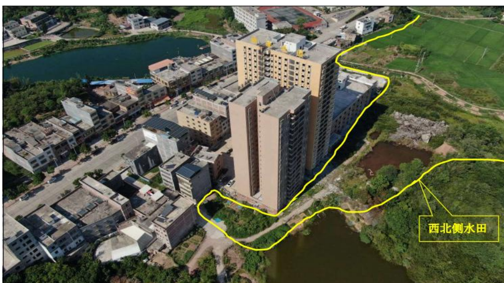
照片 2-7 1 号块西北侧水田现状俯视图（镜头朝北西）
