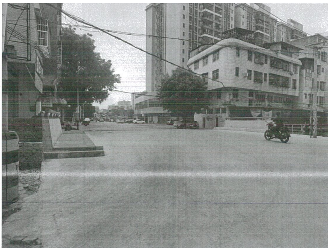
图 7 兴宁佛岭桥处置施工后
