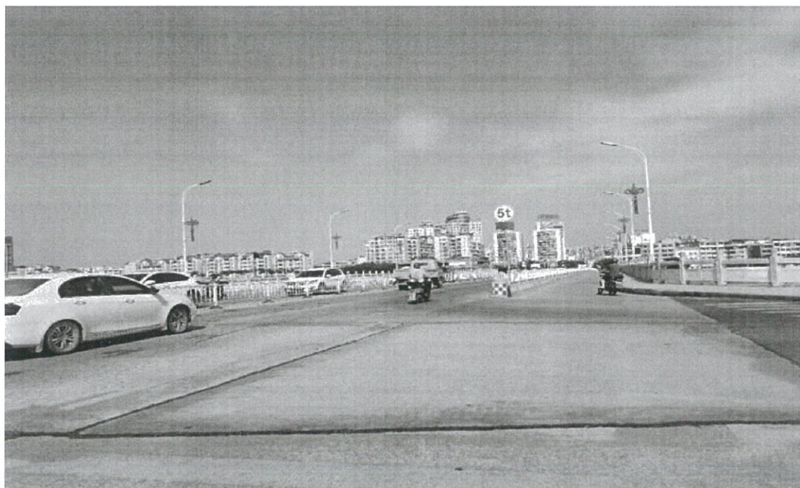
图 1 嘉应大桥施工前
