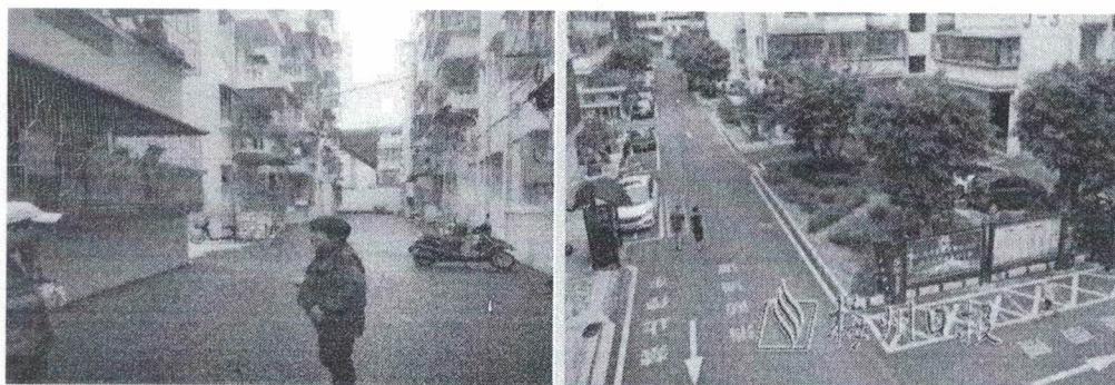
铺设沥青后道路由“洼”到“平”
