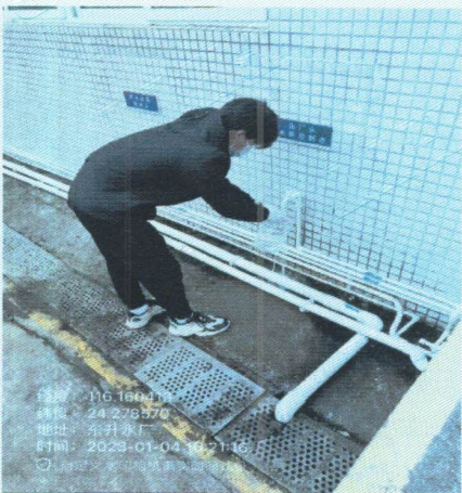
东升水厂（出厂水）
