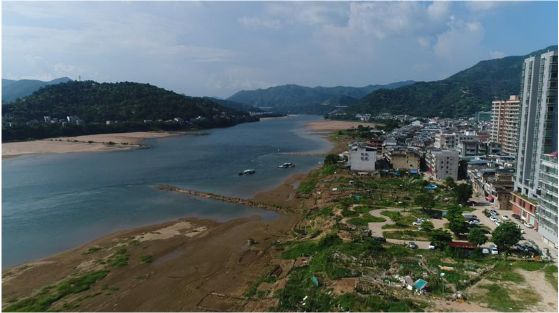
图 3.2-3 韩江高陂镇段堤防防洪工程有待进一步完善
