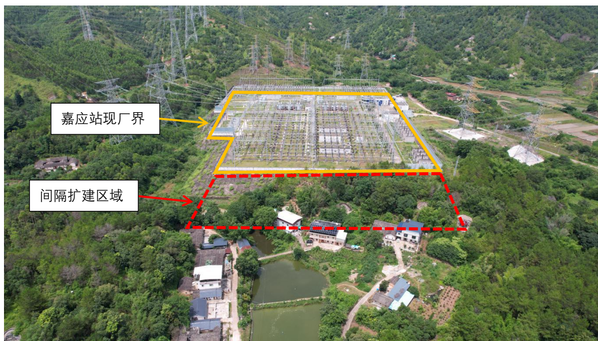
图 3.1-8 500kV 嘉应站现状照片
