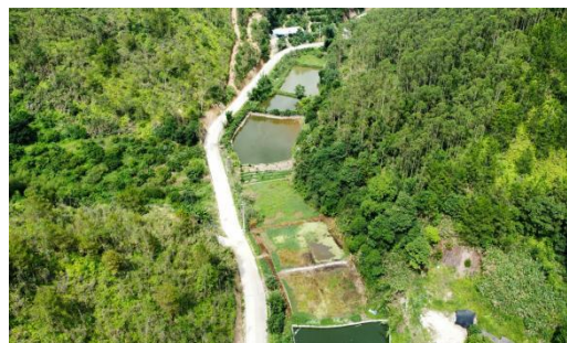
变电站西北侧现状
