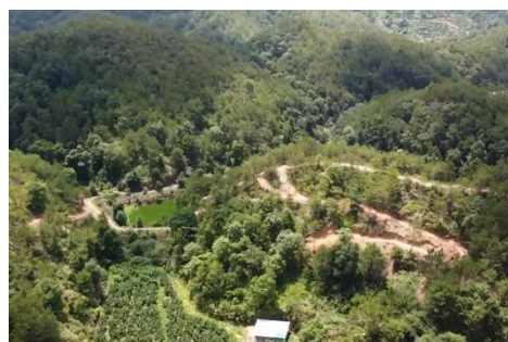
变电站东南侧现状
