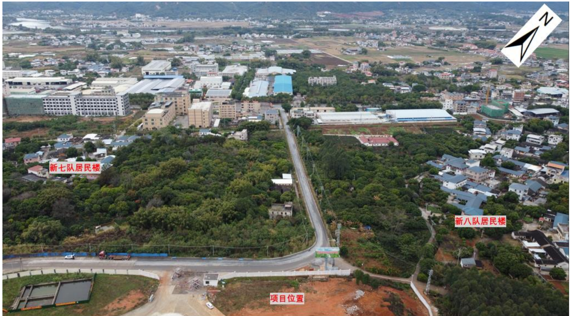
图3.1-4 在建项目最近居民点现状图
