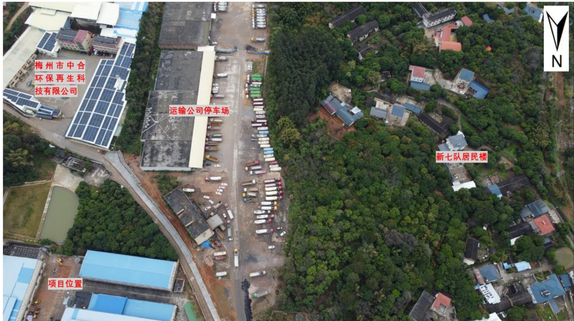
图3.1-3 在建项目周边厂区现状图
