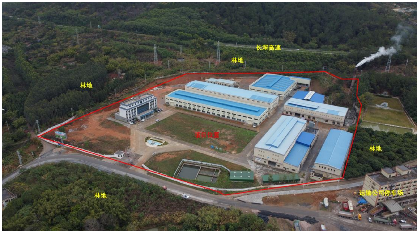
图3.1-2 在建项目四至现状图
