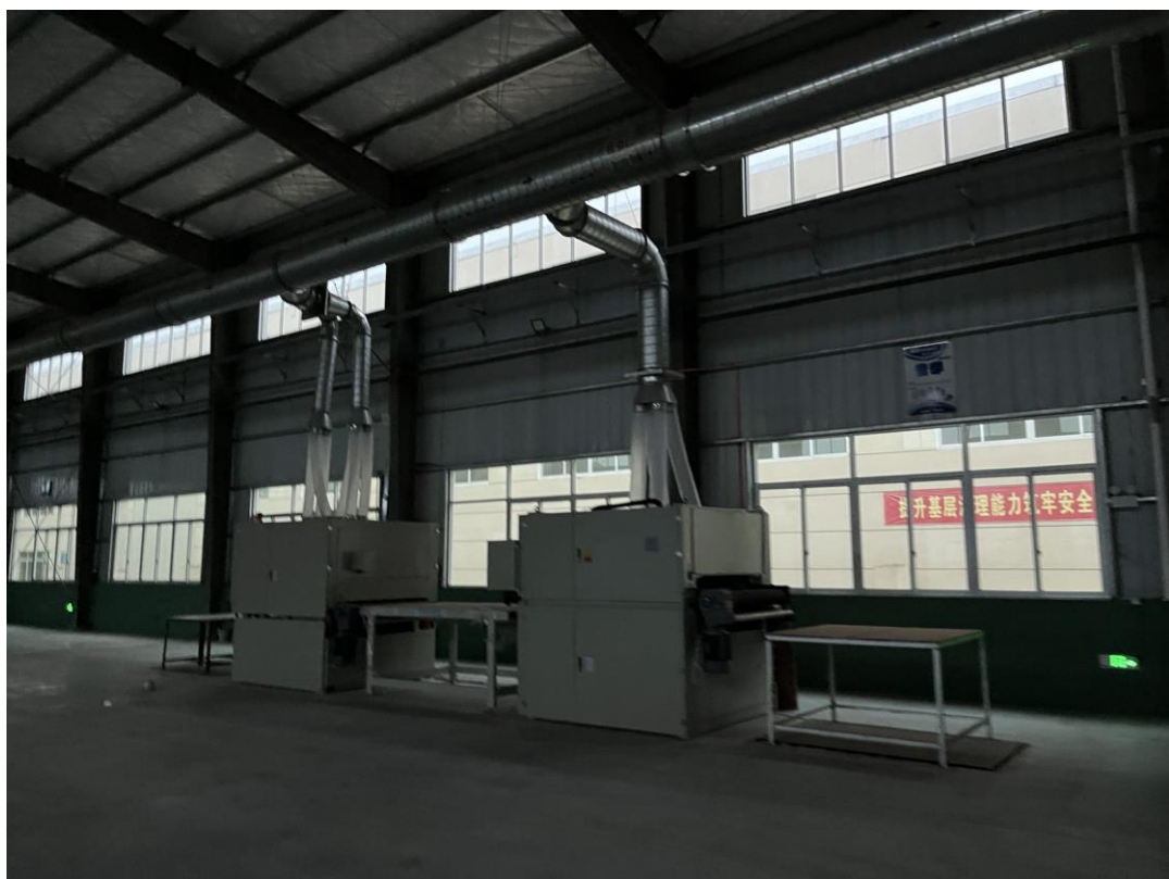
生产设备正在安装
