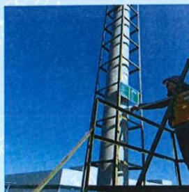
废水处理站恶臭 废气排放口
