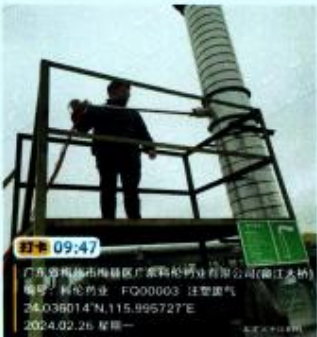
G线注塑废气排放口FQ00003
