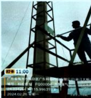
污水站恶臭废气排放口 FQ00004
