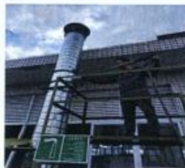
H 线注塑废气排放口
