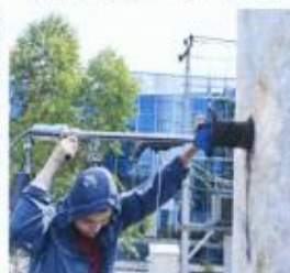
锅炉废气排放口
