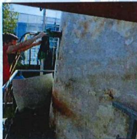
锅炉废气排放口
