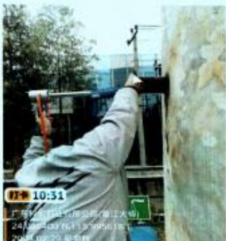
DA005 锅炉废气排放口
