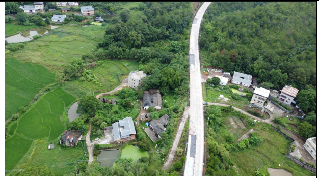
线路跨越道路现状
