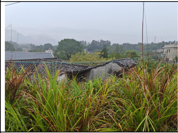
架空线路沿线现状
