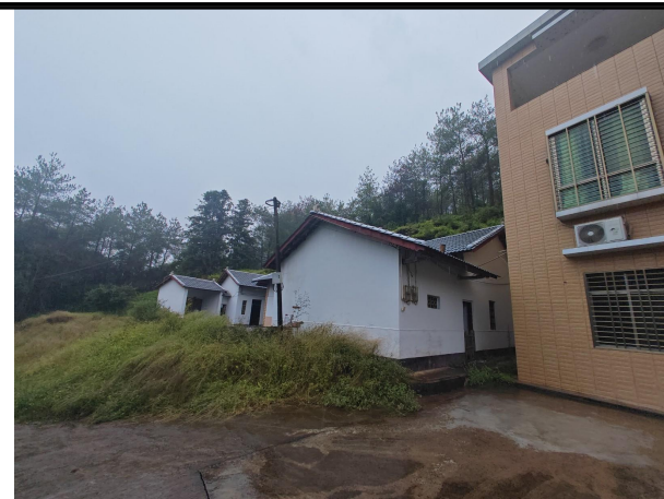
架空线路沿线现状
