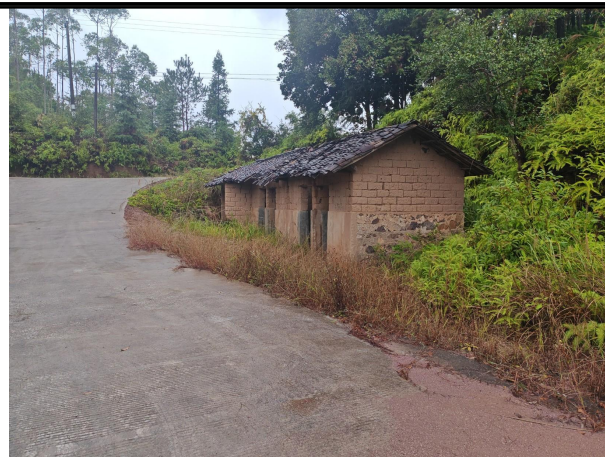
架空线路沿线现状
