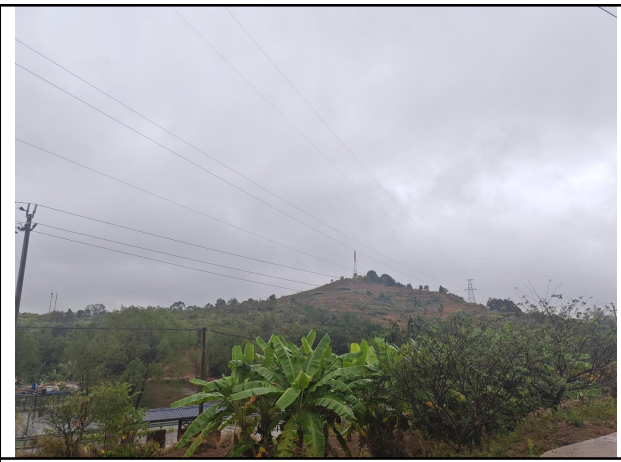
架空线路沿线现状
