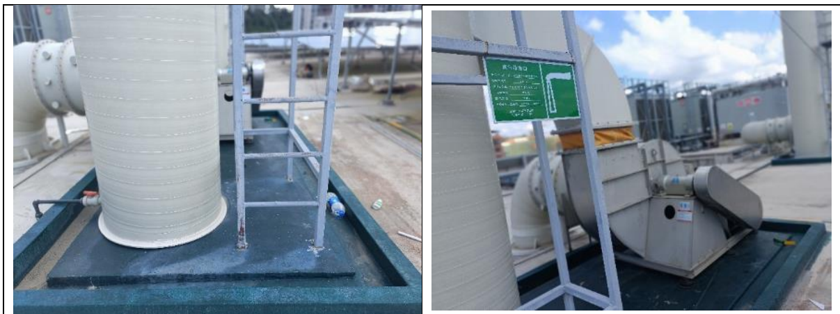
楼顶废气排放口围堰及防腐
