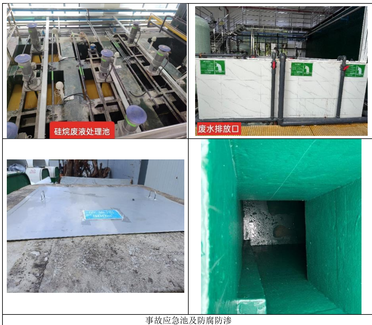
附图10 项目现状建设情况
