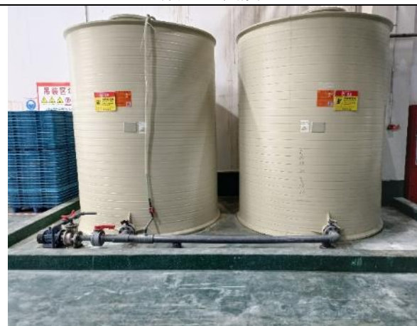
含铬浓液围堰和防泄漏沟渠
