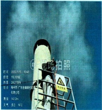
DA001 废气处理后采样口
