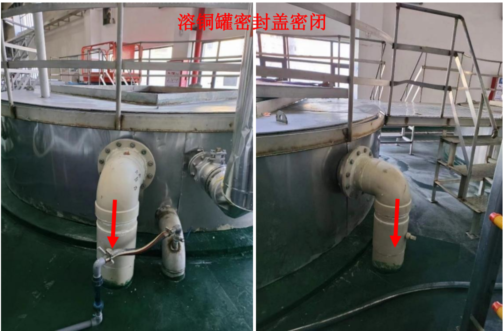
图5.1-3 溶铜罐密闭及集气管道示意图
