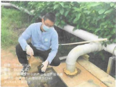
W1 自建污水处理站进水口: 第四次
