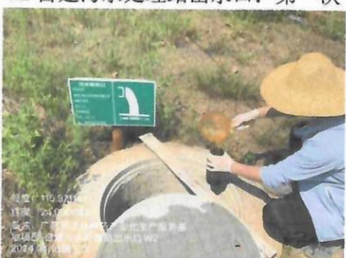
W2 自建污水处理站出水口：第三次
