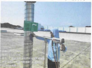
5#厂房排气筒排放口: 颗粒物第一次
