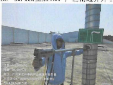
5#厂房排气筒排放口: 颗粒物第二次
