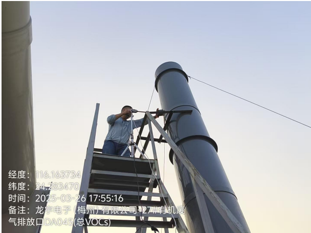
27#有机废气排放口 DA045：总 VOCs
