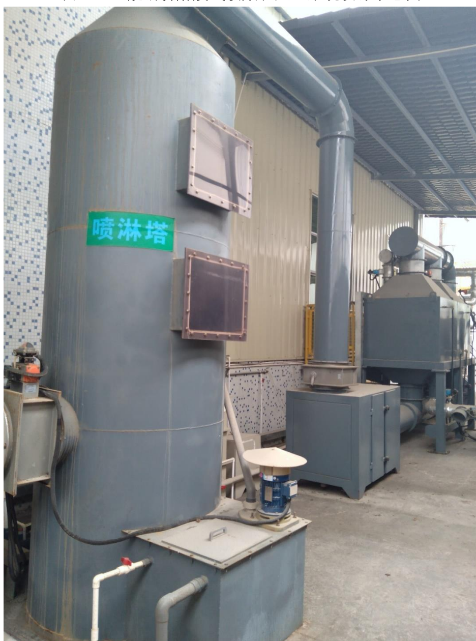
图 2.1-16 脱锡拆解废气处理系统实装图
