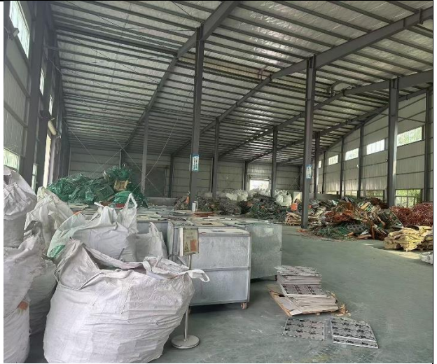
现有项目仓库现状照片
