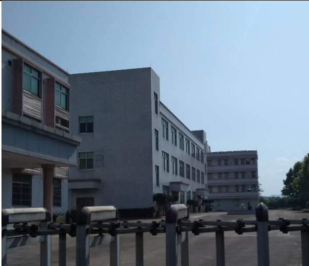
项目生产厂房现状
