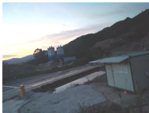
过磅站、车辆冲洗站及沉淀池
