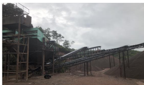
工业场地破碎筛分生产线
