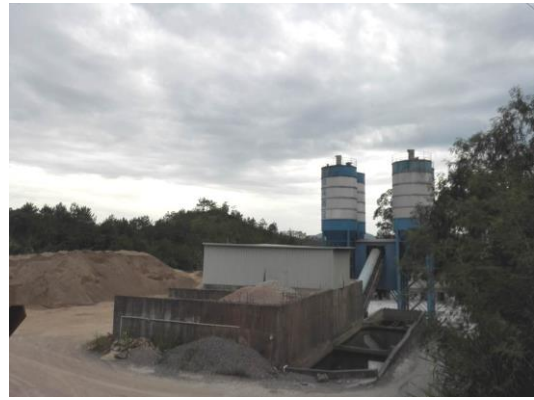
项目南侧和兴混凝土拌合站
