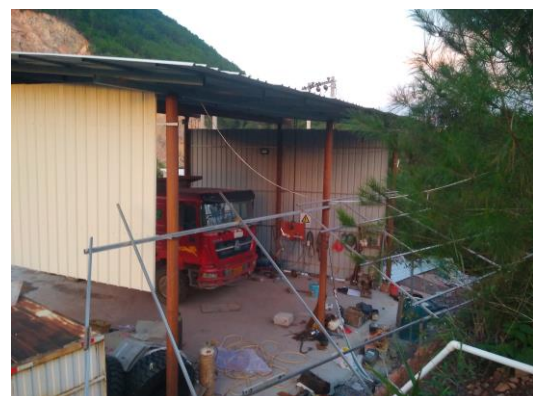
破碎站旁的机修间
