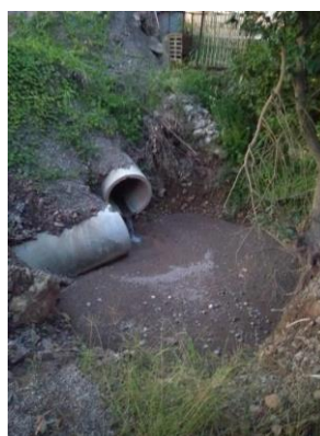
采矿区南侧、工业场地东南侧沉砂池
