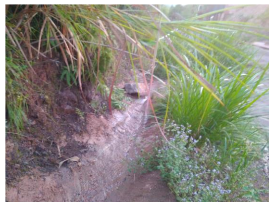
矿区道路边排水沟
