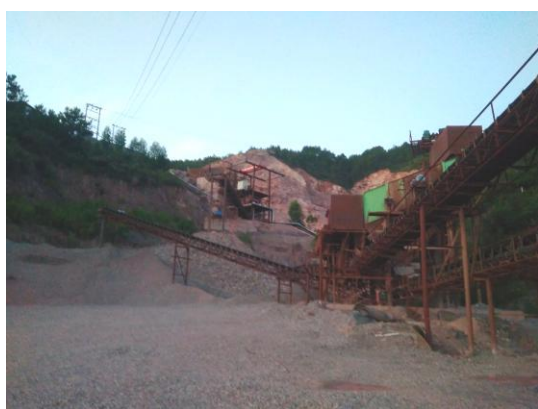
工业场地破碎区
