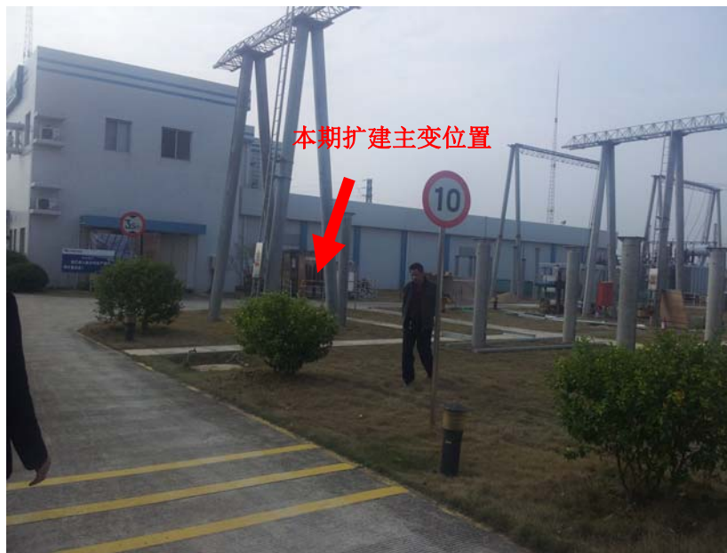
图2 110kV塘坝站主变扩建位置（前期预留）
