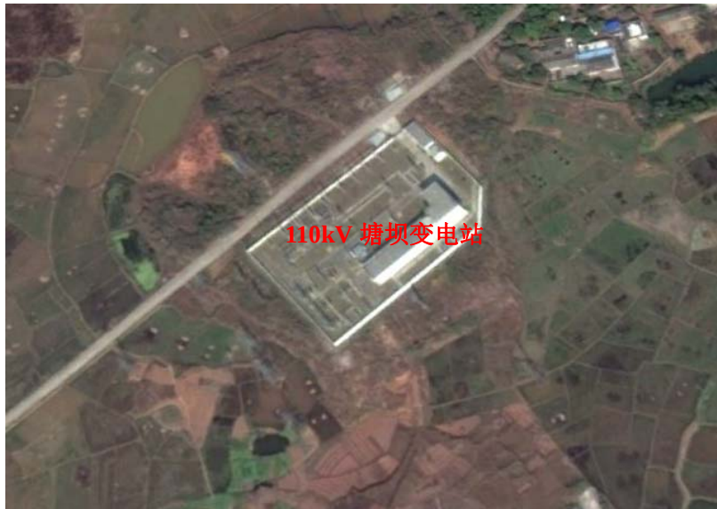
图1 110kV塘坝变电站现状Google照片
