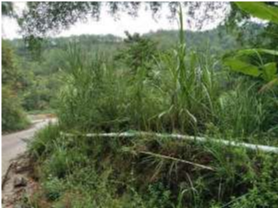
厂内道路、供水管
