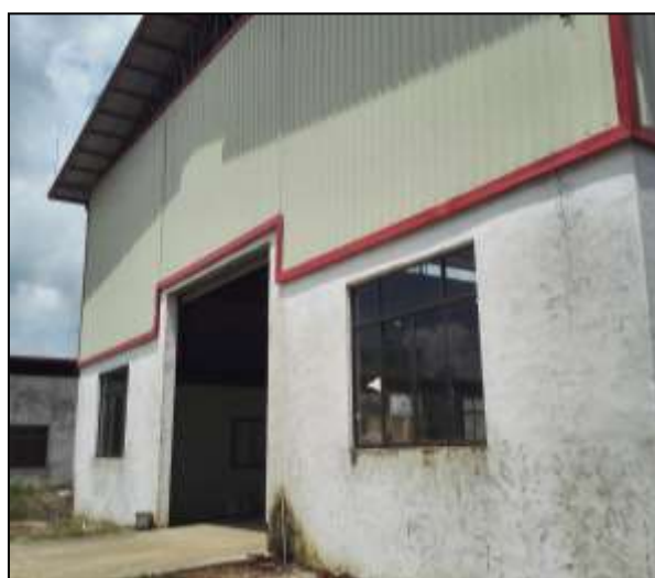
项目拟使用的已建成厂房
