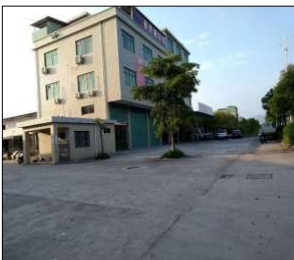
项目西面工业园道路
