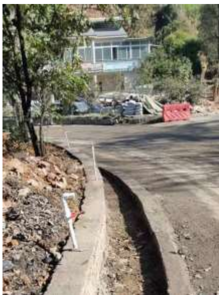
照片 15-1 运输道路抑尘措施及排水沟
