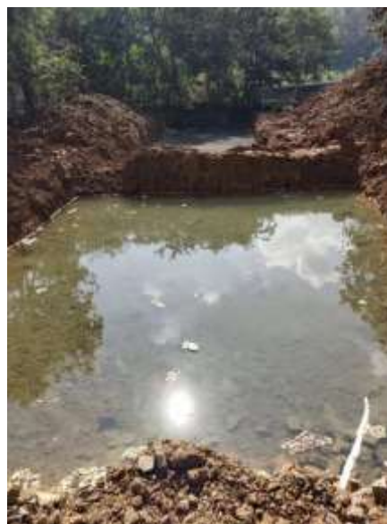
照片 15-2 新建沉沙池
