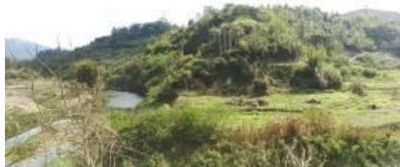
图 4.1-2 110kV 畚江丰良线路、解口 110kV 东桥至丰良甲回线路接入畚江站线路于广东省梅州市丰顺县丰良镇 G206 当风岭跨丰良河支流处
