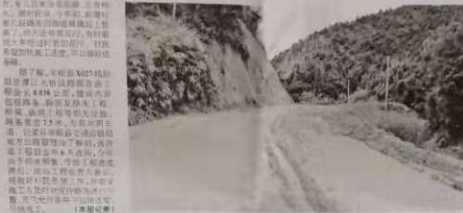
X027线砂田镇至潭江大桥段改造工程雨天泥泞不堪。
