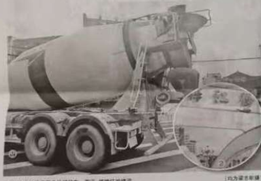
图1：从梅江桥下来的搅拌车。图2：被堵住的横梁。
