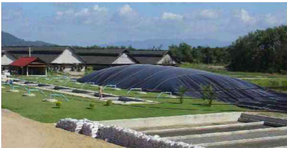
图 3.2-3 同类企业建设的盖泻湖式黑膜沼气池
