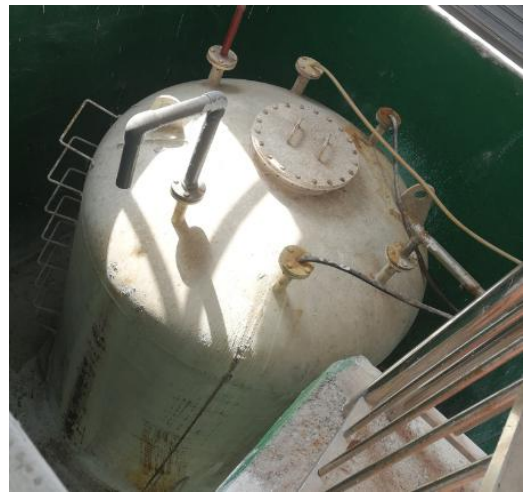
硫酸储罐围堰
