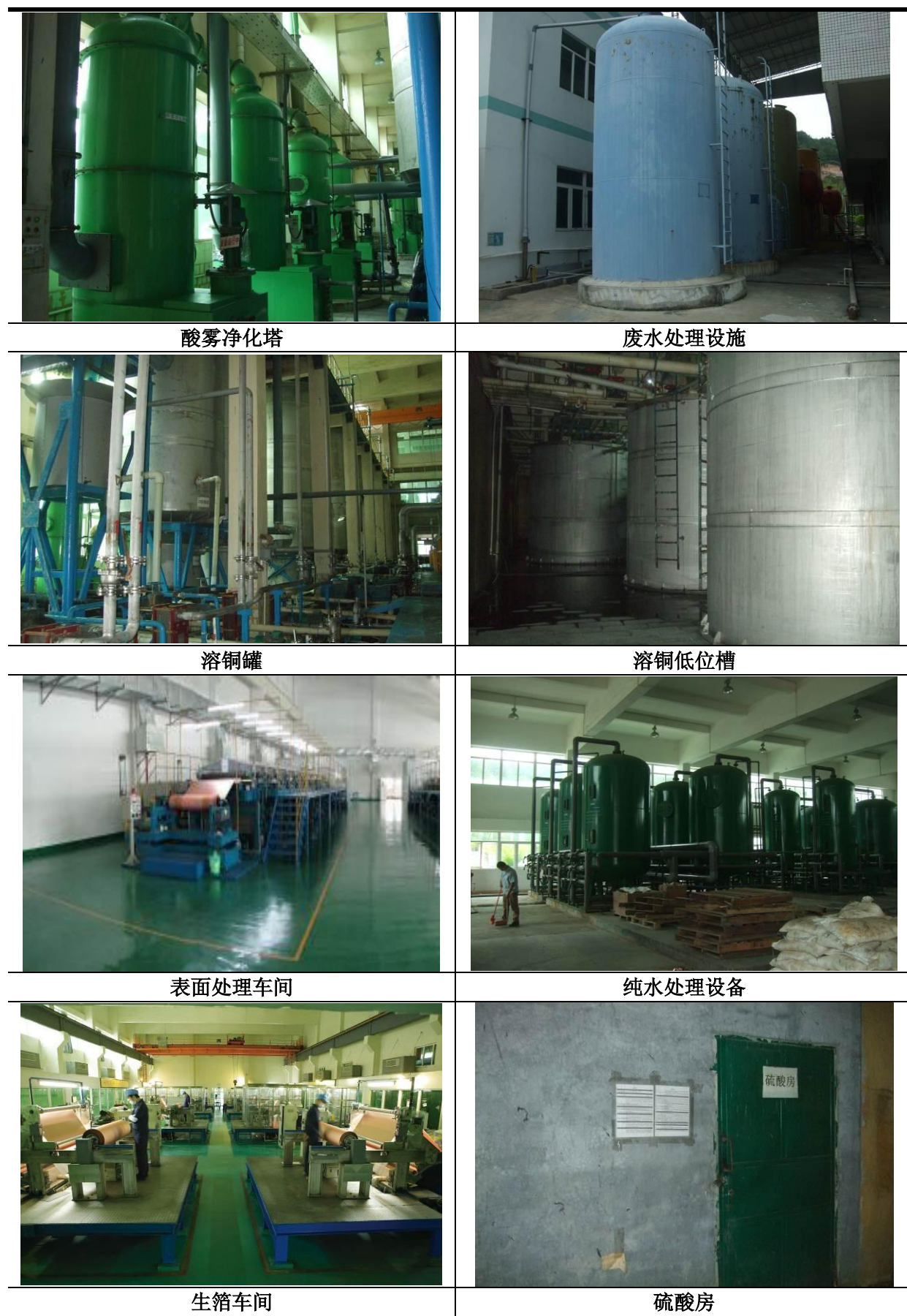
图 3.2-2 厂区现有工程实景图
