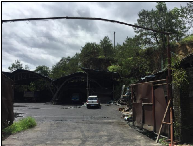
储煤厂现状照片
