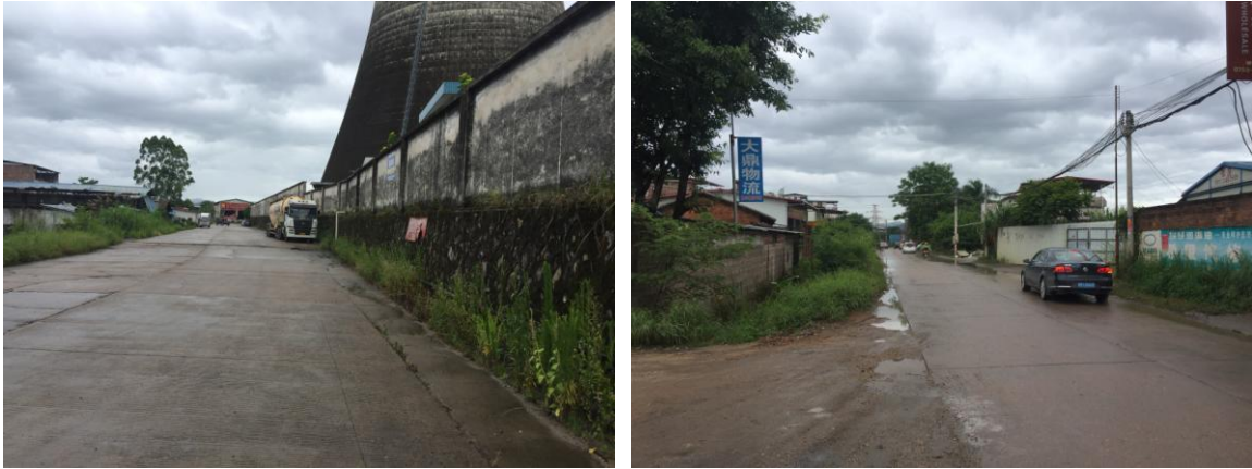
图 1-11：本工程拟建电缆线路路径现状照片
