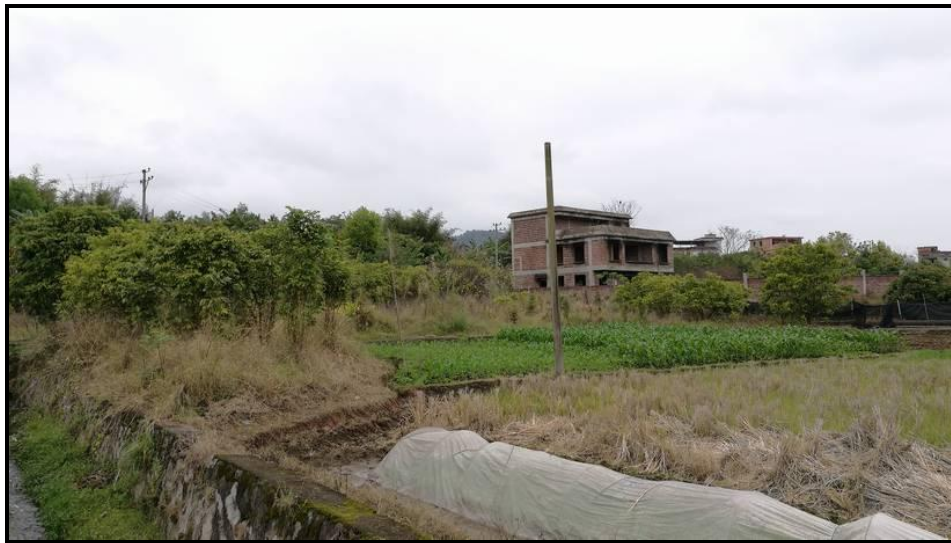
图 1-1 220kV 帅向变电站地理位置示意图及现状照片
