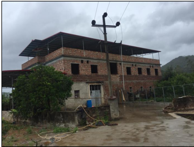
205 国道旁 2 层居民住宅现状照片
