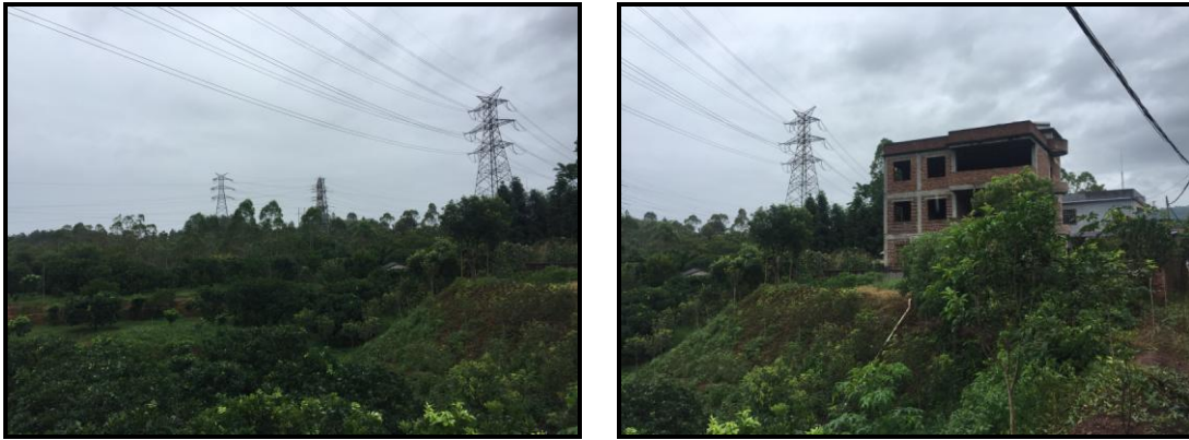
图 1-10：本工程拟建线路路径现状照片
