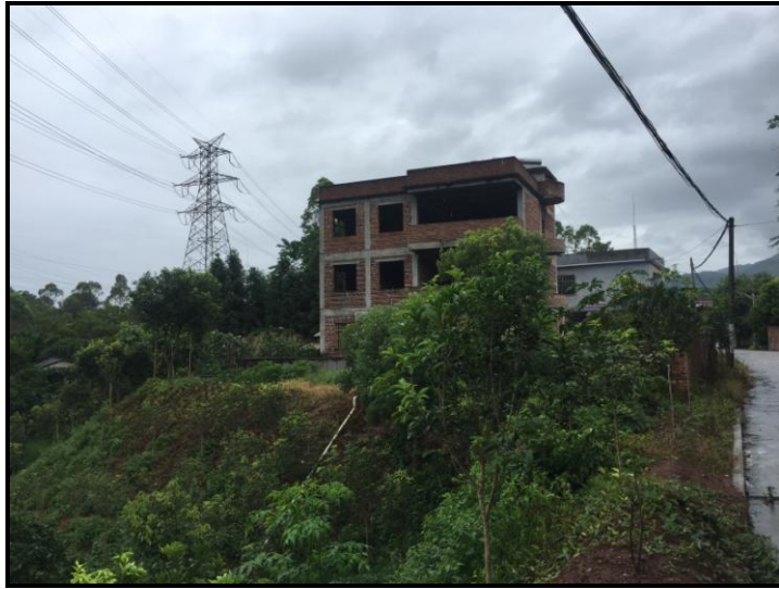
长沙村俞屋 3 层在建楼房现状照片
