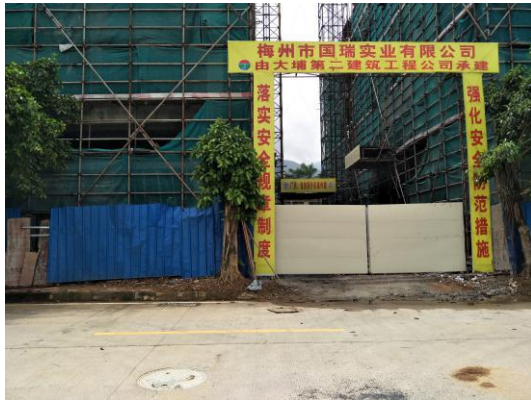
项目东面 在建的梅州国瑞实业有限公司
