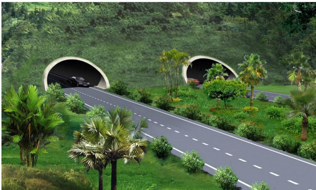
图 3.1-13 削竹式洞门效果图
